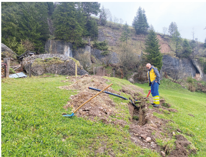
Grabarbeiten Versorgungsleitung Trieb
