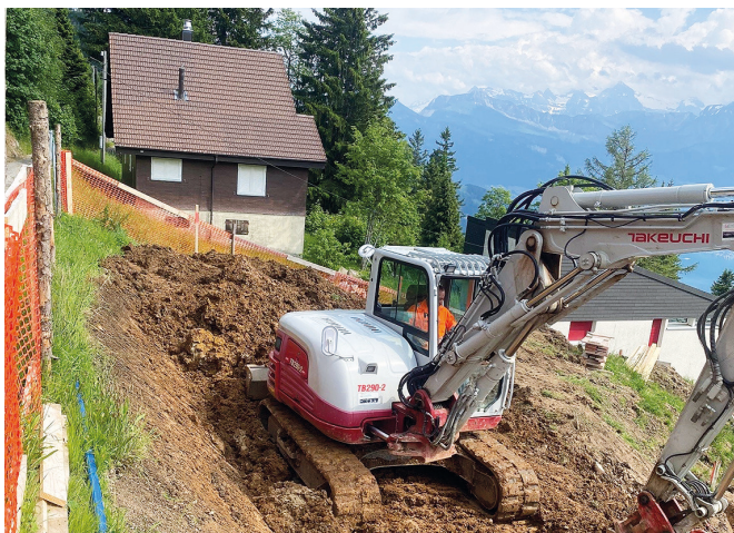
Leistungsverlegung neuer Hausanschluss Rigi First
