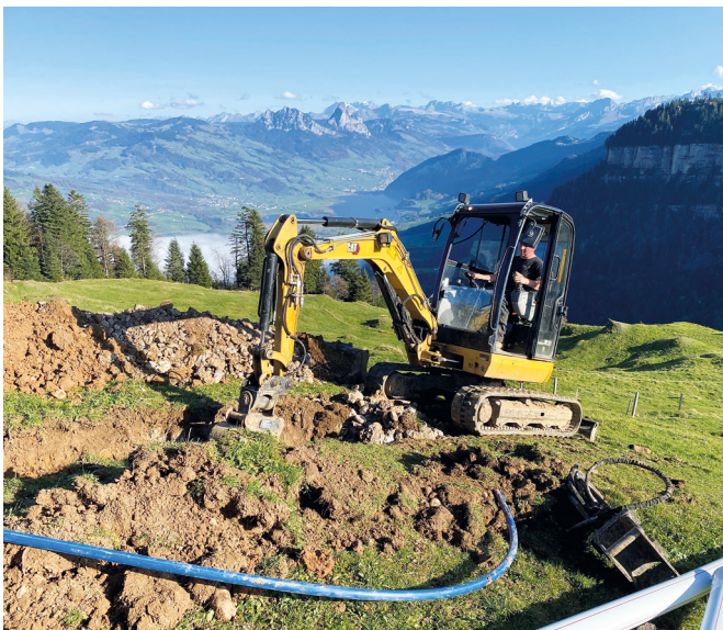
Grabarbeiten Wasserversorgungsprojekt Gruenholz
