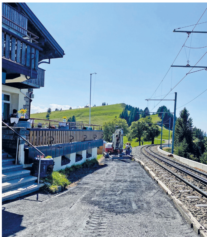
Neue Verschleisschicht Station Staffel – Schwingplatz – Rigi First
