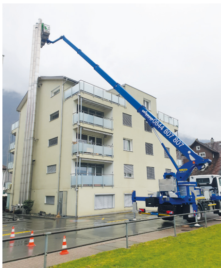
Instandsetzung Kaminanlage Arth
