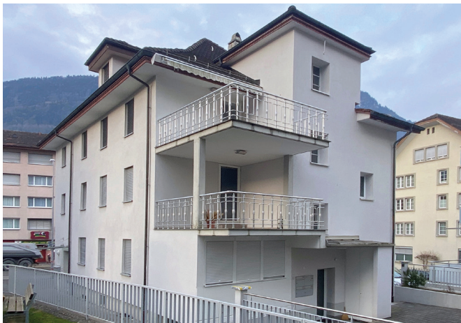
Das neu gekaufte MFH Gotthardstrasse 35
