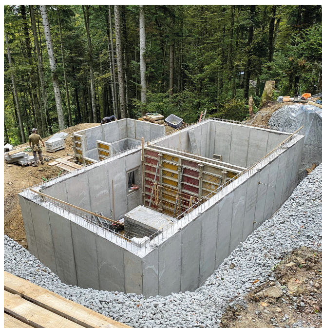
Neues Reservoir Dürrenboden für Trink- und Löschwasser
