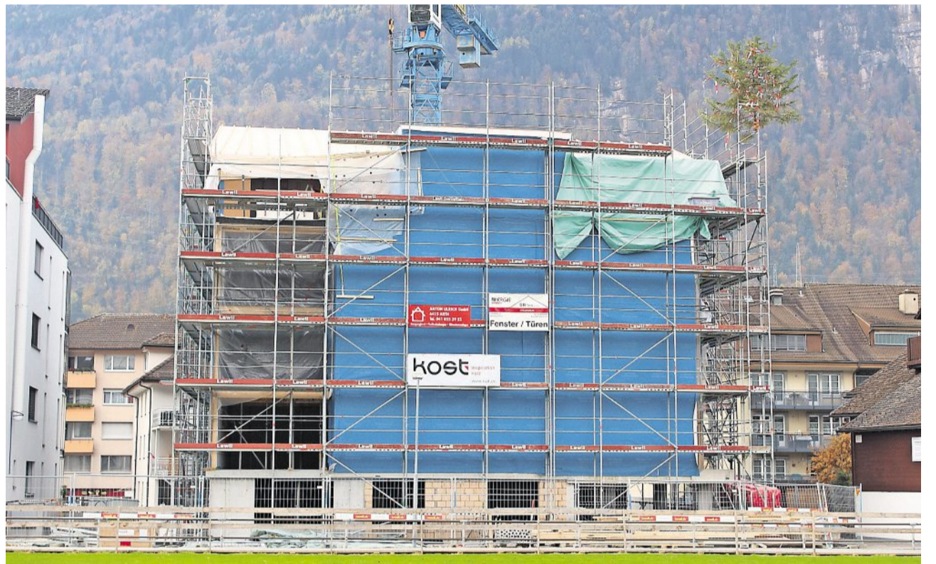
Nun hat das MFH Hofmatt der UAK die Gipfelhöhe erreicht und ist bereits mit dem Aufrichtebaum geschmückt.
